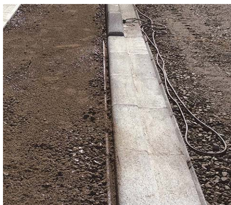
写真-6 切欠け部乳剤養生砂混入状況
