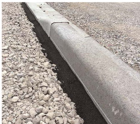
写真-5 切欠け部アスファルトレベリング
