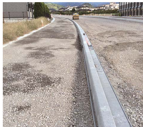
写真-3 路盤端部切下げ状況
