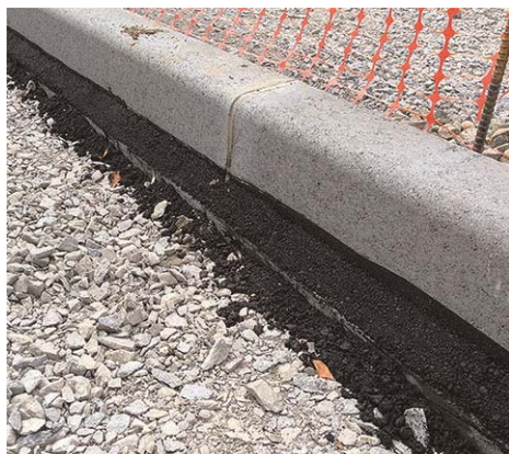
写真-7 切欠け部アスファルト合材充填状況
