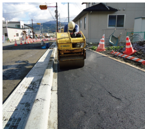
写真-9 舗装転圧状況
