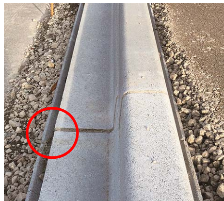
写真-2 モルタル充填状況
